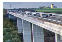
Bauwerks-Instandsetzung und Gussasphalt
