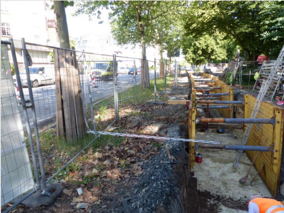
Bauüberwachung der Grabenerstellung
