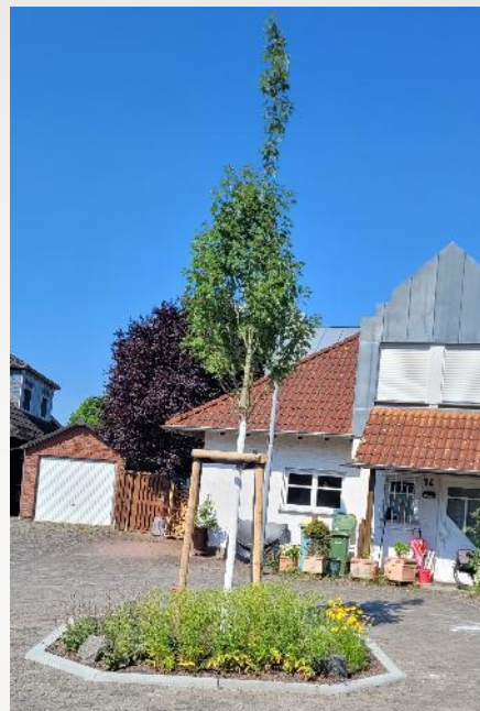
Fertigstellung der geöffneten Baumscheibe
