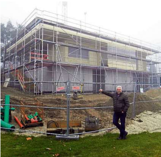
Im Bau befindlich: Das neue Domizil auf dem Rodgauer Strandbad-Gelände hat bereits Formen angenommen. 2021 soll der Innenausbau etappenweise vorangetrieben werden. Am Zaun: Bardo Neuhäusel (Foto), der führende Kopf der Stadtverwaltung in Sachen „Finanz- und Steuerungsmanagement“, schaut gelegentlich auf der Baustelle vorbei, um sich über den Fortgang der Arbeiten zu informieren.
