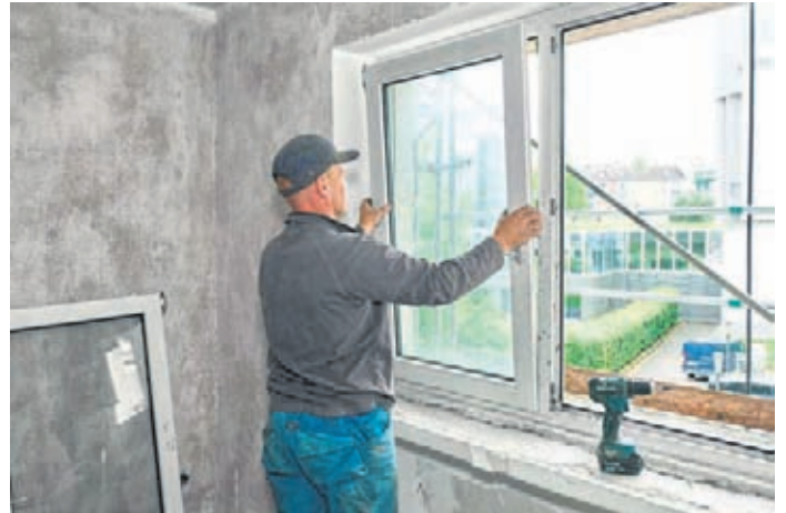
Alte Kunststofffenster werden ausgebaut und durch Modelle mit Recycling-Anteilen ersetzt. (Foto: djd/REHAU AG + Co)
