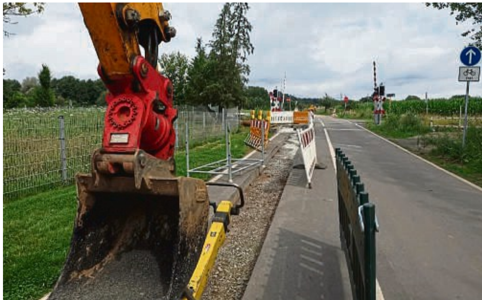
Auf dem Weg zur Bulau wird zurzeit ein 110-Kilovolt-Erdkabel zur Versorgung eines geplanten Rechenzentrums in Dietzenbach verlegt.
